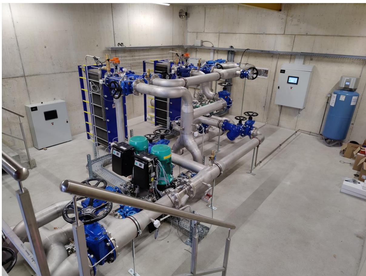
L'échangeur de chaleur du réservoir des Philosophes.
