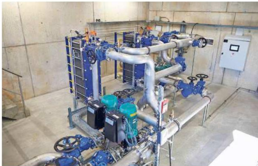
Placé près du réservoir, ce circuit fermé permet de prélever quelques degrés à l'eau potable, lesquels prendront ensuite la direction des pompes à chaleur de l'hôpital.
