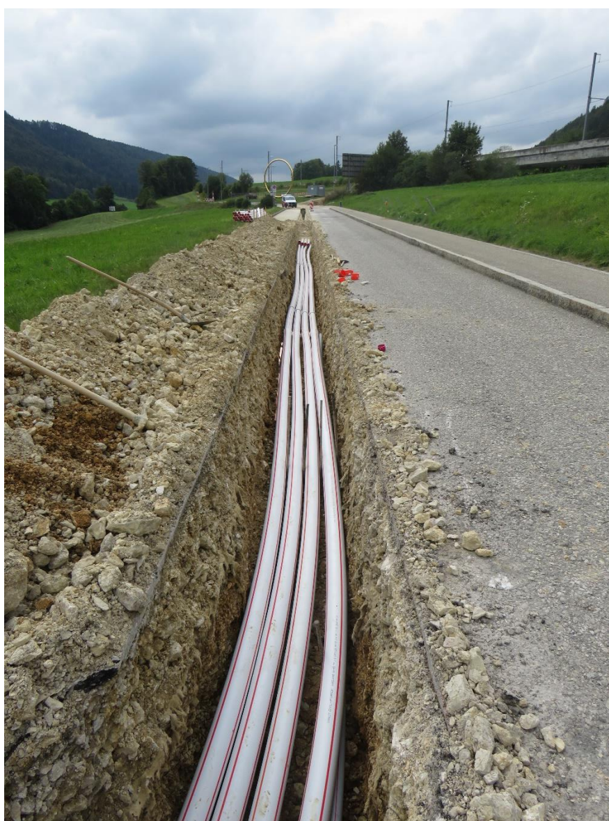
Boucllement du réseau MT et BT à la rue de la Clef.
