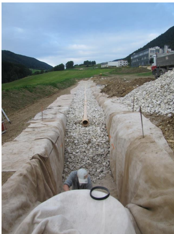
Rue de la Clef, tranchée de rétention (eaux claires) // Les Plans Champs pose du collecteur
