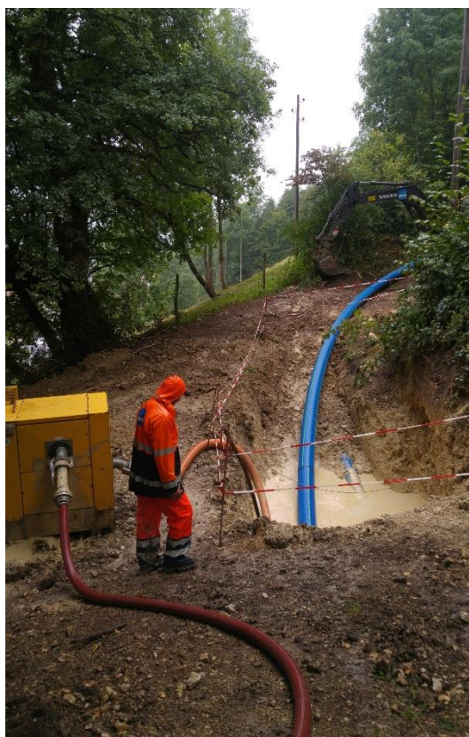
Lot 7 : Pose des conduites inter-réservoirs par forage dirigé (à gauche) et méthode traditionnelle (à droite) automne 2017.
