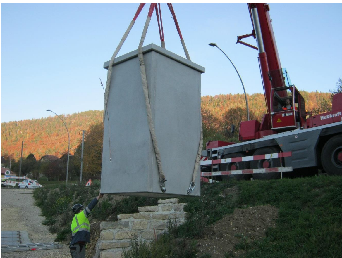
Mise en place de l'armoire de couplage MT au Sud de la Route de Villeret.
