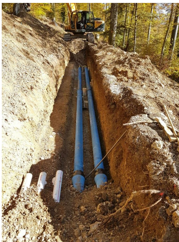
Lot 7 : Pose des conduites inter-réservoirs par forage dirigé (à gauche) et méthode traditionnelle (à droite) automne 2017.
