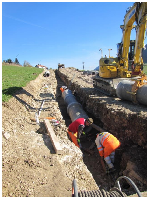
Rue de la Clef, tranchée de rétention (eaux claires) // Les Plans Champs pose du collecteur
